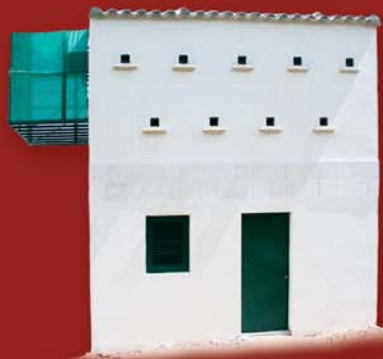
Edificio de liberación con primillar
